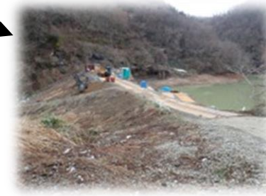
若山ダム [震度6弱～6強]
